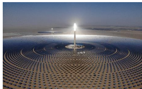
图 10 敦煌 100 MW 熔盐塔式光热电站鸟瞰图
