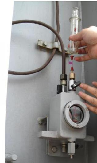
**轻瓦斯告警：反应油分解的气体压力，灵敏度高；防误动仅告警，规程规定为进一步确认是否为故障，需进行人工取气进行分析，待确认后变压器再停运，就近操作过程会对人身安全带来隐患。**
