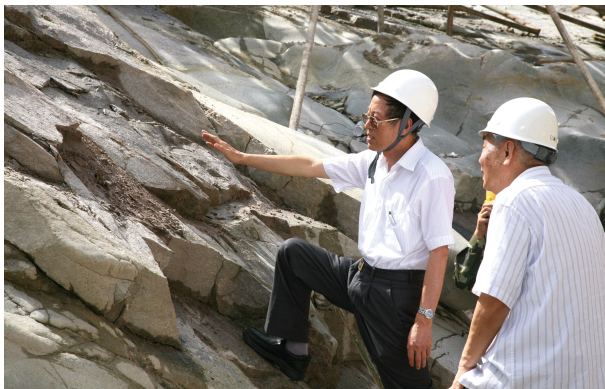
马洪琪在小湾电站认真检查工程边坡处理质量
