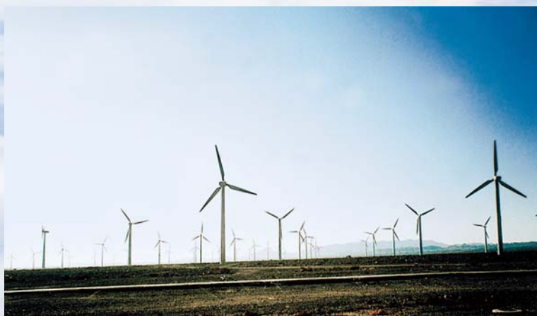
■ 新疆达坂城2号风电场为当时全国最大的风电场，共装风机147台，总装机容量75.3MW
