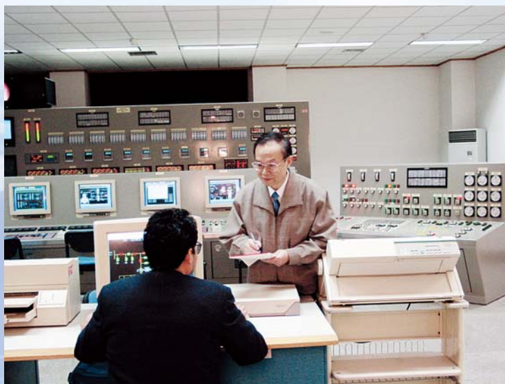
■ 中国电机工程学会高级会员、山东电力科学研究院于文虎院士，于1996年在山东电力系统建成国内第一个“大型火电机组性能及振动远程在线监测与诊断系统”，可快速诊断故障并优化运行参数
