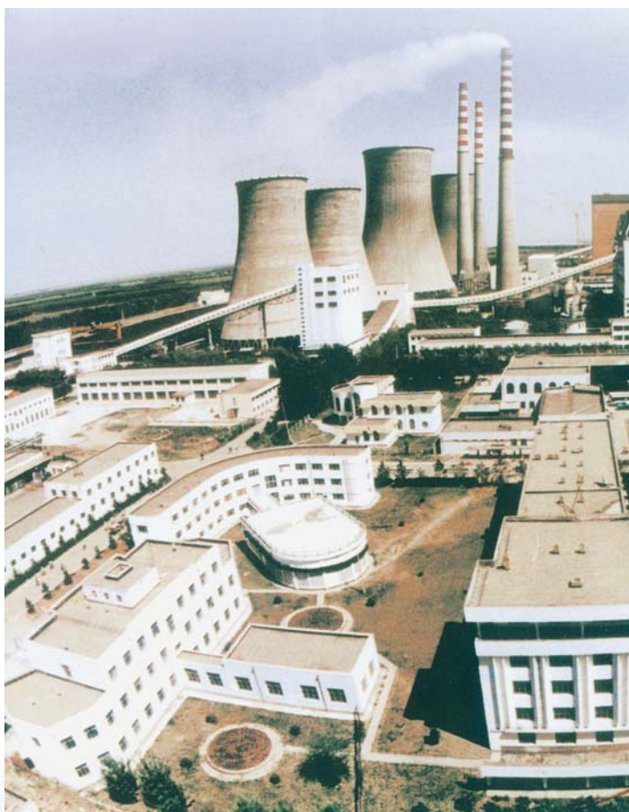
■ 第一台国产优化的600MW机组于1996年在哈尔滨第三发电厂投入运行。图为装有2台国产600MW亚临界火电机组的哈尔滨第三发电厂全景全貌
